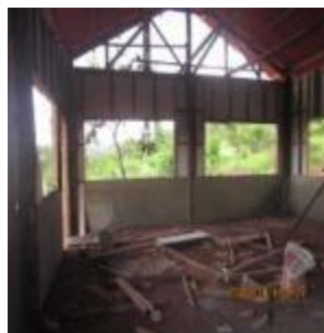
建設中の様子
