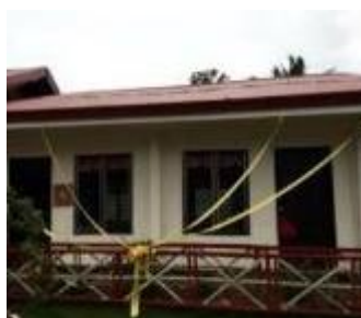
完成した小学校
