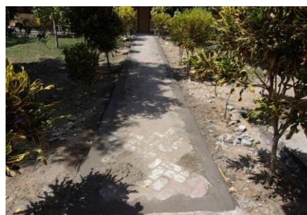
歩道が完成しました
