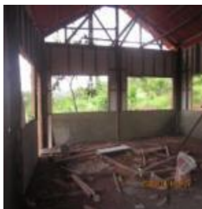
建設中の様子
