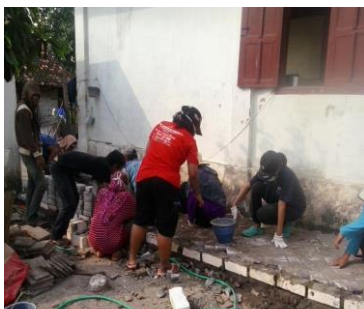
力を合わせて歩道を修繕
