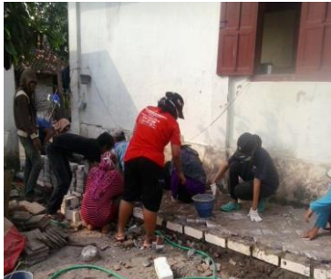
力を合わせて歩道を修繕
