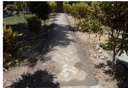
歩道が完成しました
